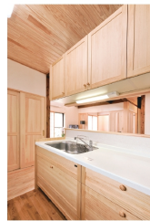
キッチンも無垢材で造作。統一感のある仕上がりになりました。水廻りの造作はFAMILY&HOUSEの得意分野の一つです。
